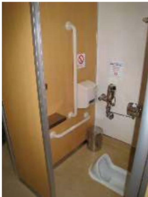
蹲式廁所扶手採倒T型，底下水平扶手約40公分長，距地面40公分，中間與地面垂直之扶手長約60公分與水平扶手距離約10公分。
