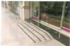
平台深度不足
