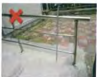
扶手端部未做防勾撞處理，視障者易撞擊突出物。
