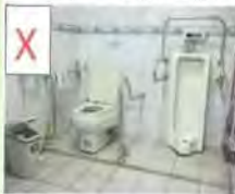
錯誤的扶手型式設置及方式
