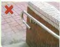
扶手端部未做防勾撞處理，視障者易勾住衣物。
