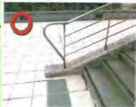
樓梯扶手端部防勾撞處理
