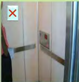
▲ 副操作盤過於內側、扶手設置不當
