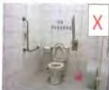
扶手距馬桶中心的距離左右不對稱，高低也不相同。
