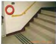
樓梯扶手端部固定於牆上防勾撞
