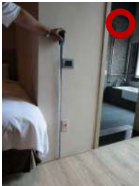
房間內應設置高度90-120公分、35-45公分 共二處求助鈴，以供輪椅乘坐者求助需求。
