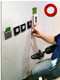
電器插座及開關應設置高度70-100公分處， 以方便輪椅乘坐者使用。
