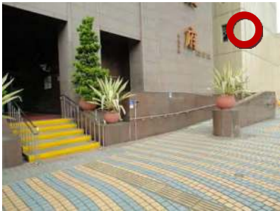
坡道旁設有階梯時，其階梯應設置終端警示設施，以便於視障者使用階梯。
