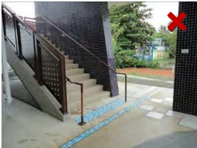
扶手水平延伸不得突出走道上，以防止碰撞危險。
