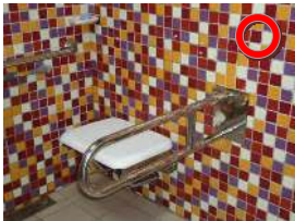
輪椅進入式淋浴間入口側邊座椅處設置可動扶手
