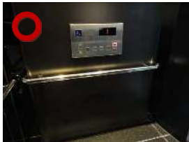
輪椅乘坐操作盤設置位置正確案例
