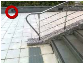
樓梯扶手端部防勾撞處理
