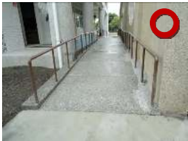
坡道扶手端部防勾撞處理
