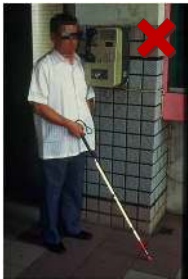
室外通路設置突出物，應設置警示或其他防撞措施，避免視障者撞到。
