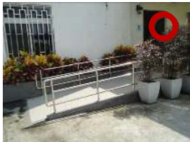
坡道扶手端部防勾撞處理
