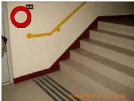
樓梯扶手端部固定於牆上防勾撞
