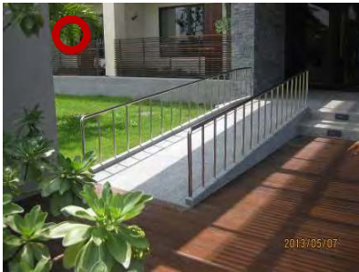
坡道終端應設置長寬各150公分以上之端點平台，方便輪椅通行。
