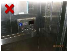
輪椅乘坐操作盤，距入口距離小於30公分，不方便操作。
