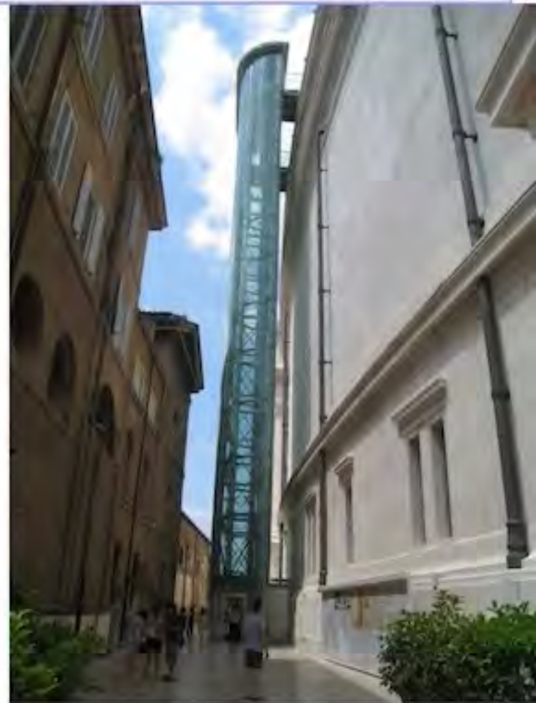
升降機設置於建築物後面，完全不影響古蹟之外觀
