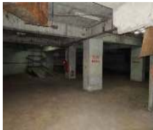
現況照片：車道
