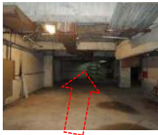
現況照片：車道
